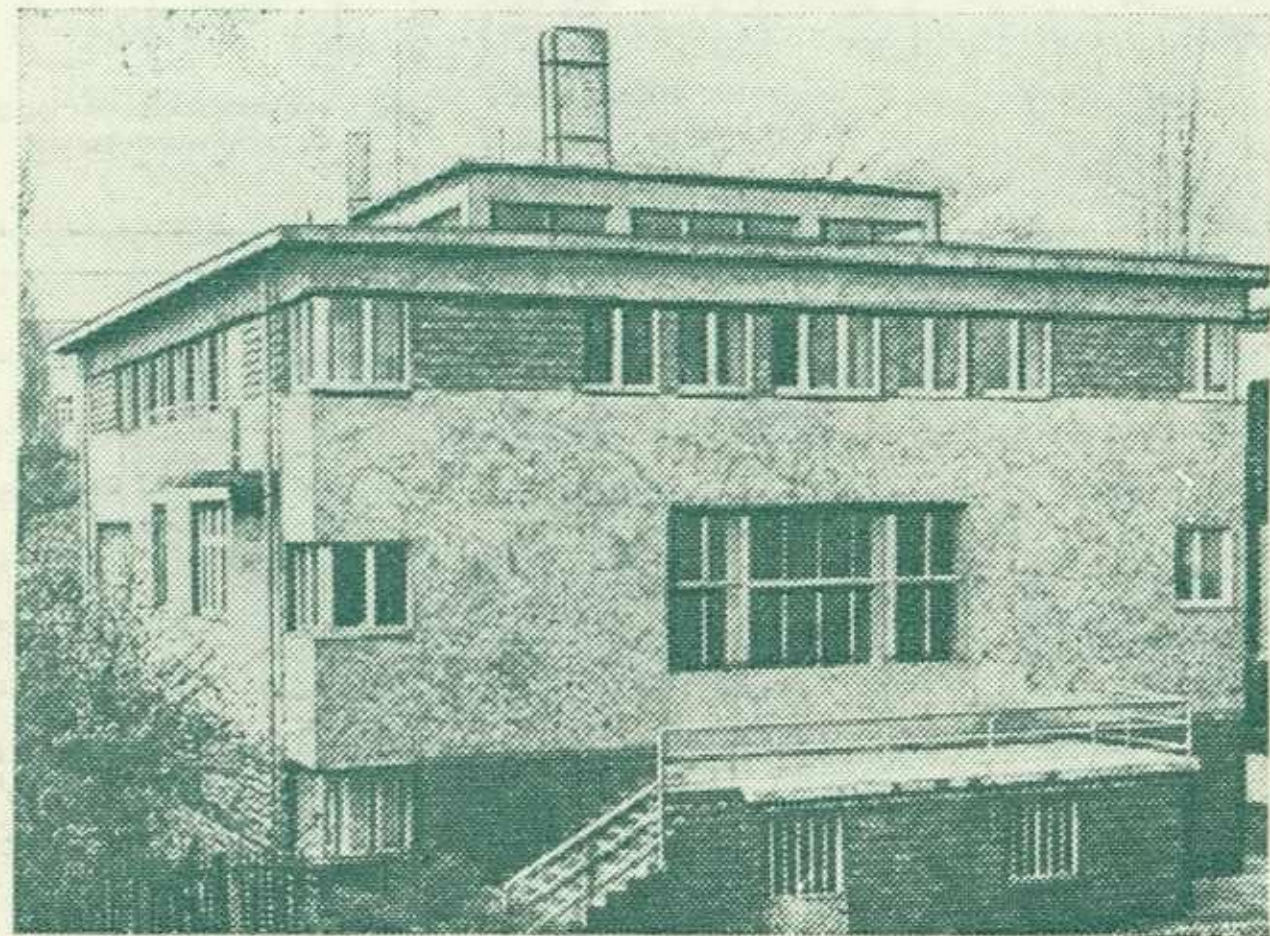
1. Здание профсоюзной школы в Лейпциге. Автор Й. Нимейер. 1928 год
